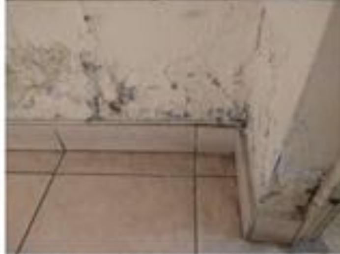
3 - ammassamento della fascia inferiore di intonaco lungo le pareti perimetrali inferiori alla
