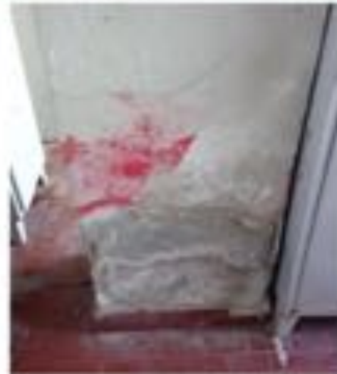
3 - ammassamento della fascia inferiore di intonaco lungo le pareti perimetrali inferiori alla
